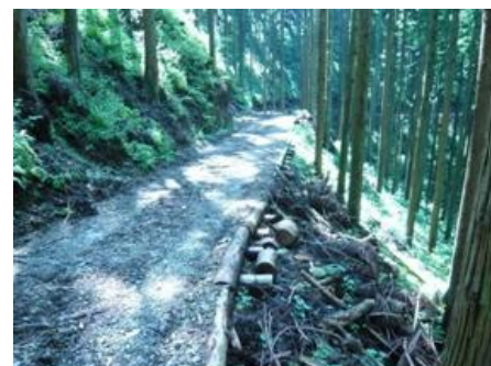
図2 急傾斜地に作設された作業道
